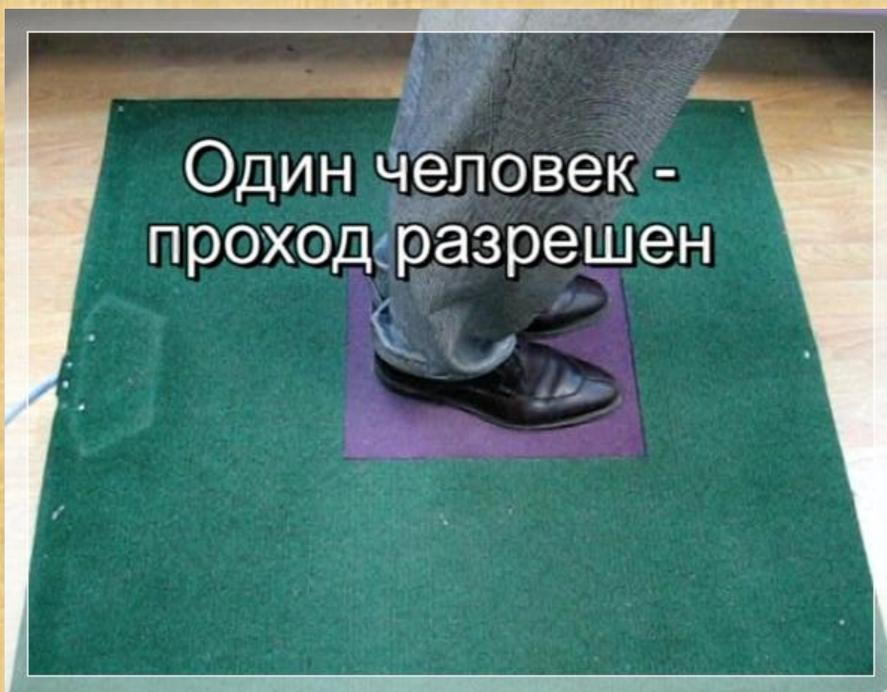
9. Внешняя дверь шлюза закрывается. (Примечание: При открытой внешней двери или наличии 2-х или более человек в шлюзе внутренняя дверь шлюза не открывается)
